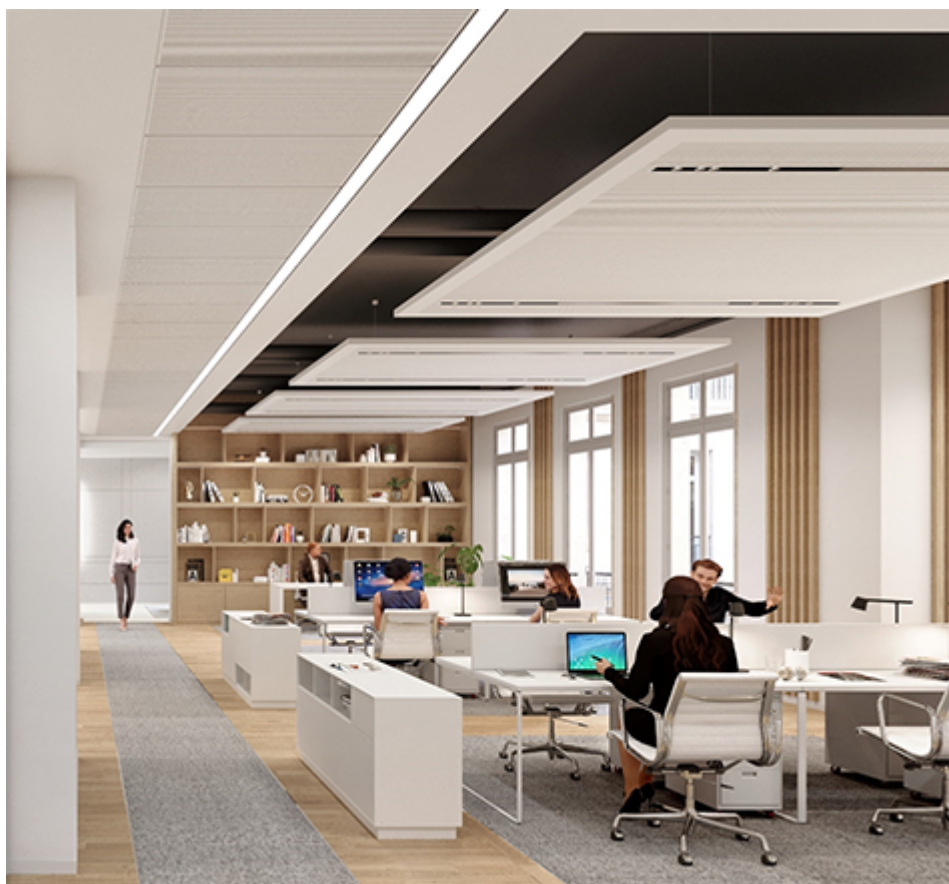
Fig.2. Les unités TTAP sont ici de couleur noire et installées au-dessus d'un îlot de plafond.
