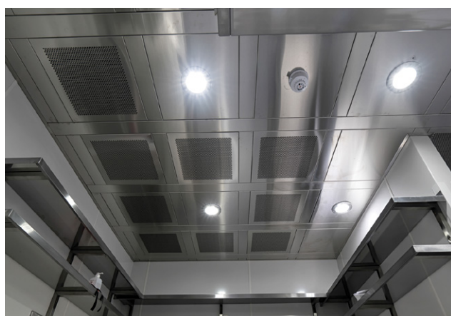
2 Cassette perforée (compensation) 1 Cassette d'extraction des graisses 3 Cassette spots Cassette lumineuse 4 Cassette passive
