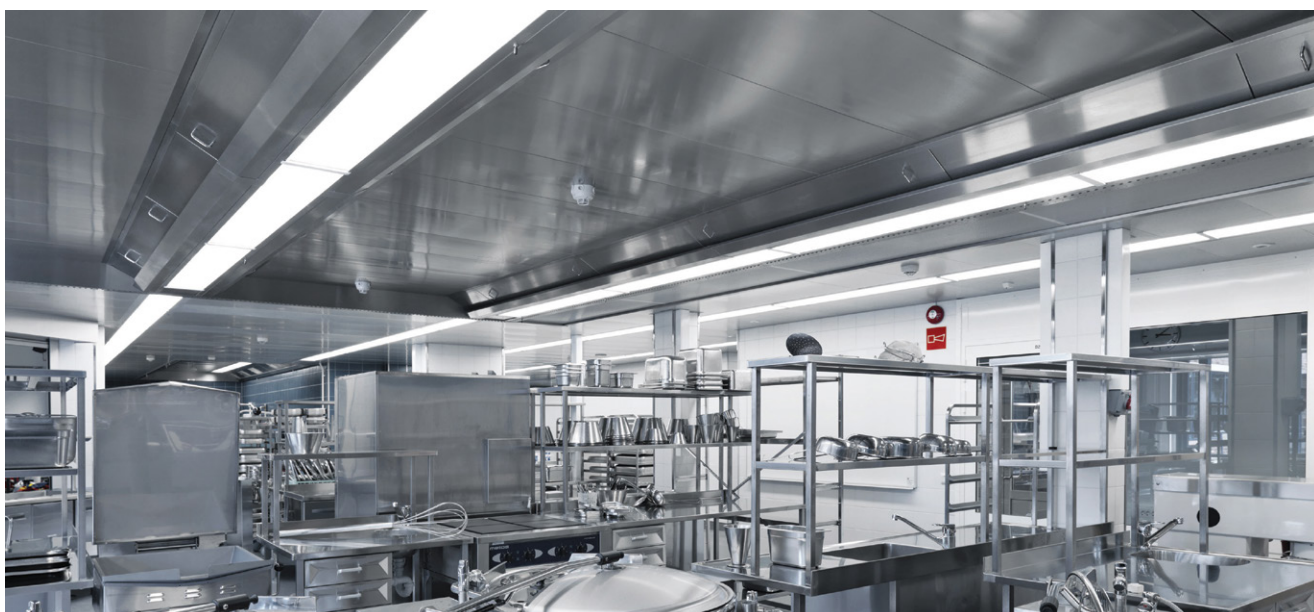
Zentralküche Kotka (Kotka, Finnland)
