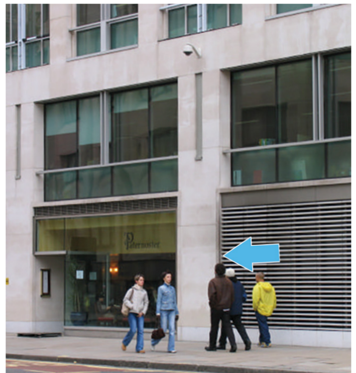
Dion and Pater Noster 餐厅（伦敦）厨房内安装了一台 PolluStop 装置。排放点位于大厦正面。
