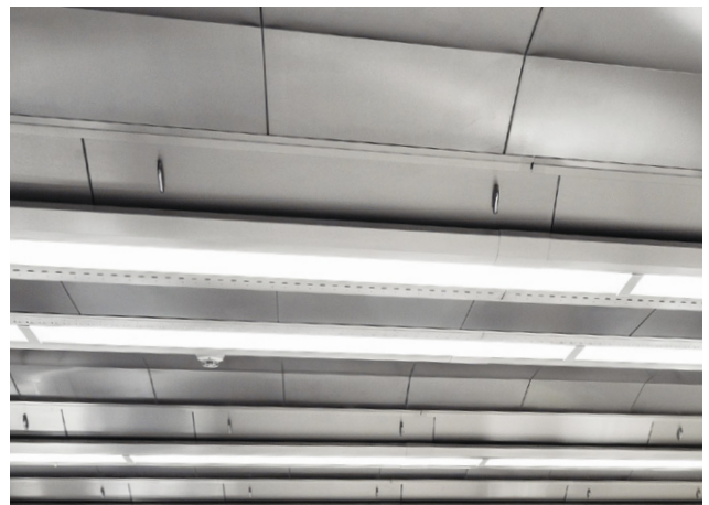
采用水洗技术的双天花烟罩排气室剖面图 (KCW)。
