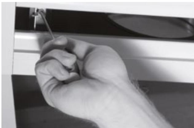
5. Engager les vis de fixation à l'intérieur des trous pré-perçés. Accrocher les têtes de vis à l'entretoise.
