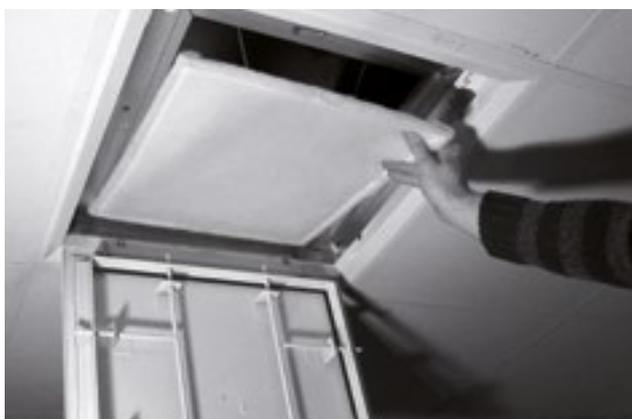
7. Faire pivoter les supports à 90° et retirer le filtre. Installer un nouveau filtre dans la même position. Fermer le panneau frontal en appuyant sur le déclenchement push-pull (diffuseur ouvrant).
