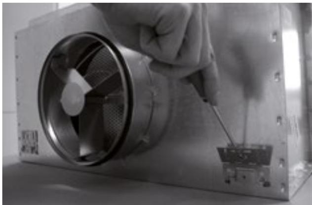
1. Dévisser les 4 supports à l'aide d'un tournevis et pencher pour insérer les tiges filetées M8.
