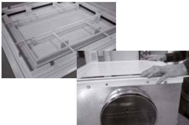
2. Pour des diffuseurs de dimensions 600x600, le diffuseur est fixé au plénum au moyen de clips.
