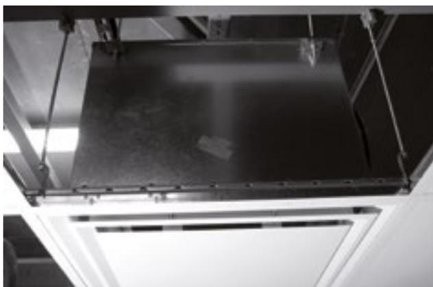
3. Le plénum est installé dans un plafond suspendu avec des tiges filetées et raccordé à la gaine de ventilation.
