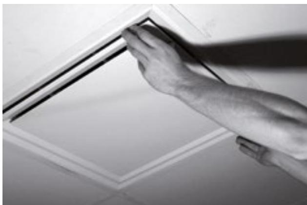
4. Système d'ouverture (diffuseur ouvrant)
