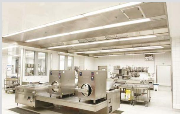
Jet技术而改善。小型喷气机齐平安安装在烹饪区。该小型喷气机把热量和杂质导向排气装置，改善了捕捉和吸纳效率。低速空气散流器将清新空气带入工作区。
