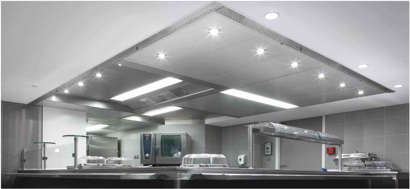
Basalte Building (Paris La Défense, France)
