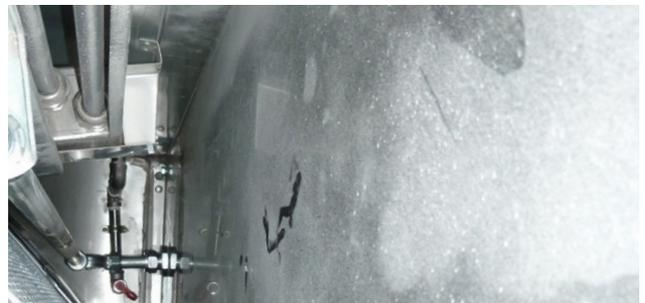
UV-C 램프가 장착된 배기 플레넘을 12주간 사용한 내부 모습
